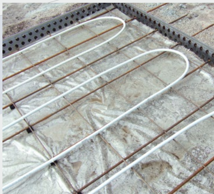
Треформ и бетон образуют монолитную конструкцию высокой прочности
